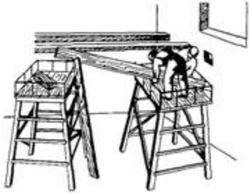
Рис. 25. Опускание перепиленной балки на подмости
