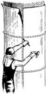
Рис. 44. Разгиб горизонтального фальца
