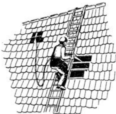
Рис. 11. Устройство проема в обрешетке
