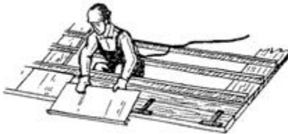
Рис. 16. разборка карнизного свеса
