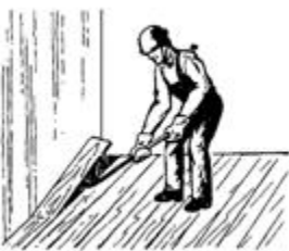
Рис. 31. Отрыв крайней доски
