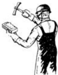
Рис. 47. Очистка кирпичей от раствора
