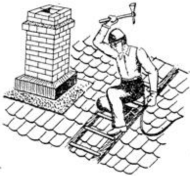
Рис. 14. Вырубка стяжки в примыкании
