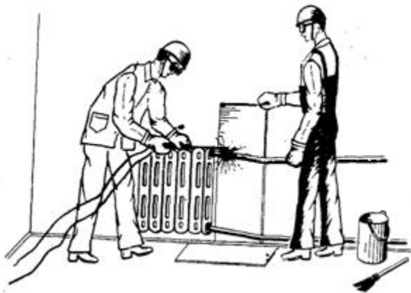
Рис. 55. Перерезание верхней подводки
