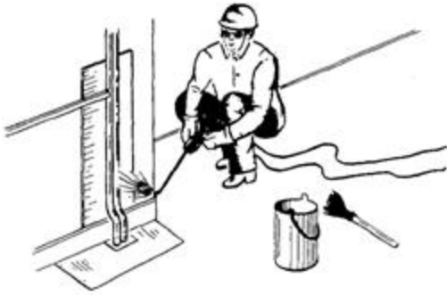
Рис. 57. Перерезание стояков
