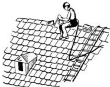
Рис. 12. Разборка коньковой черепицы
