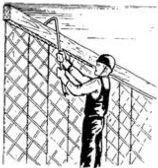
Рис. 37. Отрыв брусков обвязки
