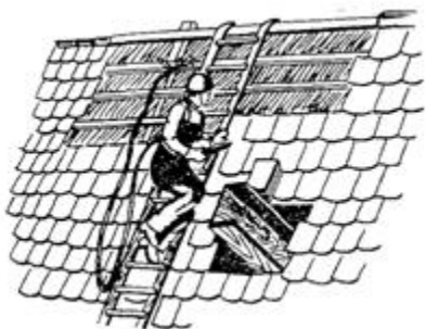
Рис. 13. Разборка рядовой черепицы
