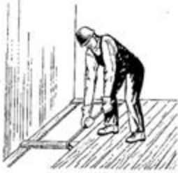
Рис. 32. Отрыв соседних с крайней досок
