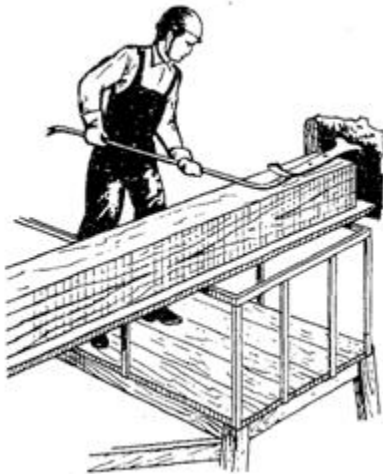
Рис. 23. Освобождение балки от анкера
