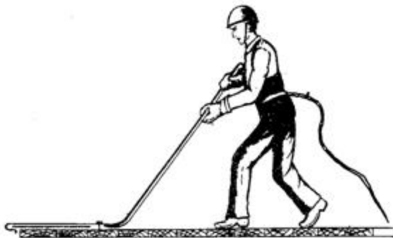
Рис. 9 Снятие карнизного свеса
