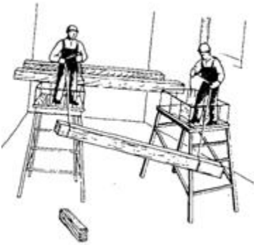
Рис. 26. Опускание балок на пол
