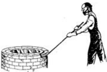
Рис. 46. Разборка кирпичной кладки
